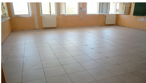
Réfection du carrelage à l'école G. Rascol
