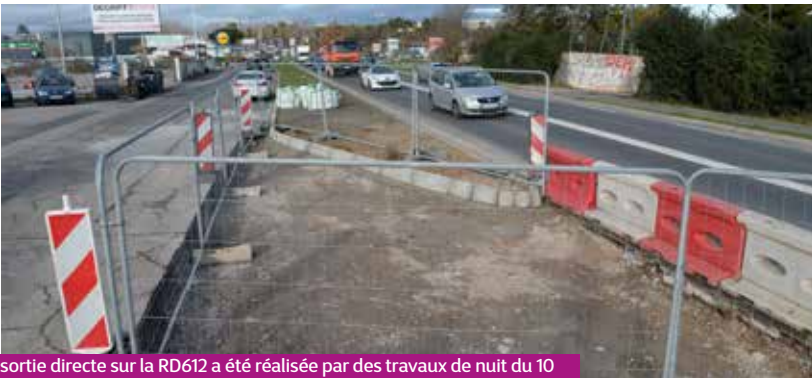
La sortie directe sur la RD612 a été réalisée par des travaux de nuit du 10 au 19 décembre 2019.
