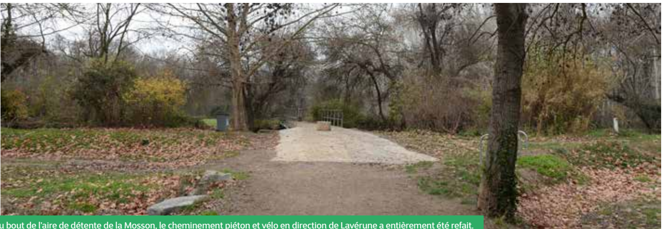
Au bout de l'aire de détente de la Mosson, le cheminement piéton et vélo en direction de Lavérune a entièrement été refait.
