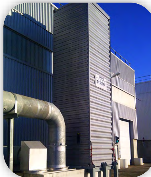
Caisson de charbon actif vertical affecté au traitement de l'air issu de la fosse de réception des OMR.
