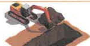
Travaux en cours d'eau
